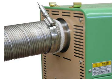
エア漏れ防止用ガラステープ施工例
