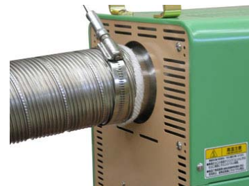
エア漏れ防止用ガラステープ施工例
